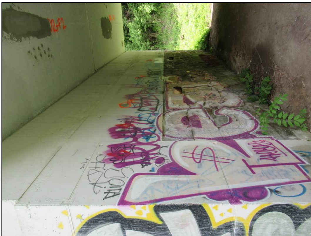
Obr. č. 6 - pohled na opěru Maloměřice. Původní horní část spodní stavby byla ubourána a nahrazena konstrukcí z betonu.
