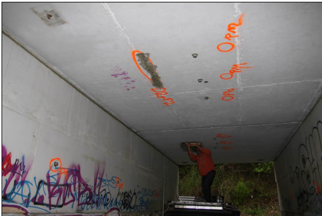
Obr. č. 9 - pohled na nosnou konstrukci, vlevo jsou za sebou patrné dvě sondy pro ověření výztuže , vpravo pak prováděné odtrhové zkoušky na spodním líci NK P7 - P12
