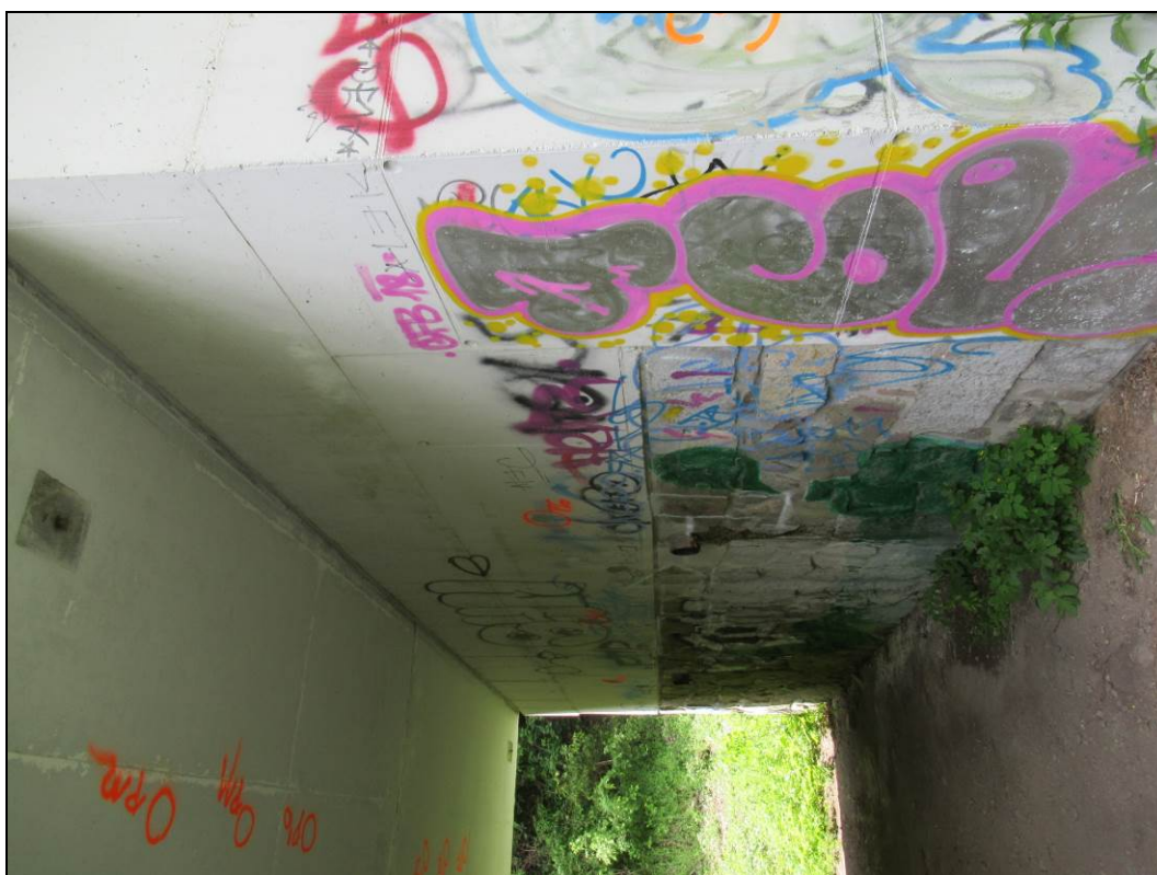
Obr. č. 7 - pohled na opěru Adamov. Původní horní část spodní stavby byla ubourána a nahrazena konstrukcí z betonu.
