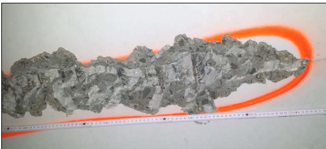
Obr. č. 10 - detailní pohled do sondy ve spodním líci NK na odhalenou výztuž v levé části NK
